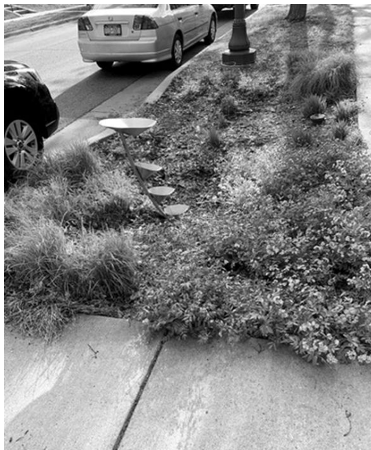
Рис. 11. Газон на бульварі, перетворений на «дощовий сад»: зрізаний бордюр для регулювання рівня зливової води (Barnes, 2022)
